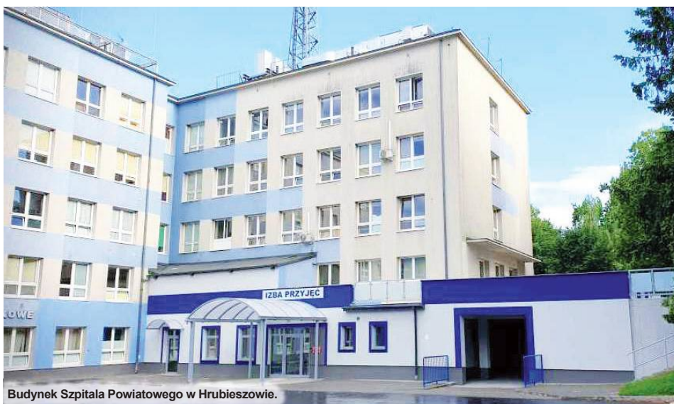
Budynek Szpitala Powiatowego w Hrubieszowie.
