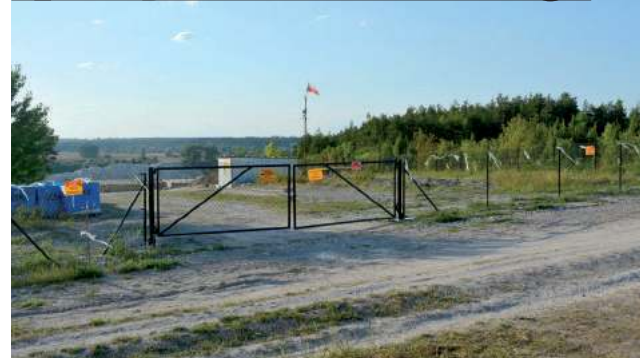
Kontrowersyjna budowa w Kazimierzu – stan na lipiec 2019. Zdaniem przeciwników inwestycji pozwolenie na budowę nie powinno zostać wydane, bo budowa zaburza nadwiślański krajobraz i znajduje się w cennym przyrodniczo terenie
