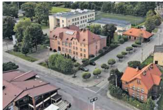
Gotowy jest projekt na część forum od targowiska przed budynkami szkoły. Magistrat ma pozwolenie na budowę i można ruszać z inwestycją
