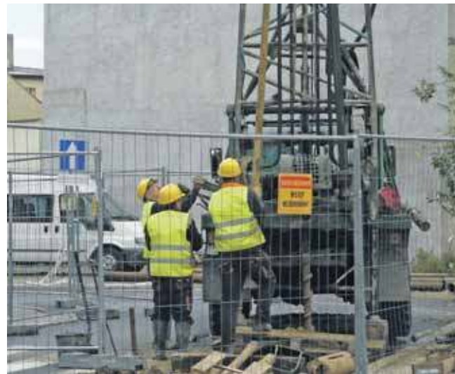
Prace polegały na wtłoczeniu techniką wiertniczą do podziemnych pustek i szczelin tworzywa geotechnicznego
