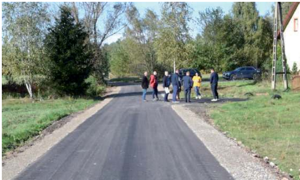
Nowa asfaltowa droga ma długość 547 metrów. Jej budowa rozpoczęła się w ubiegłym miesiącu i już zakończyła
