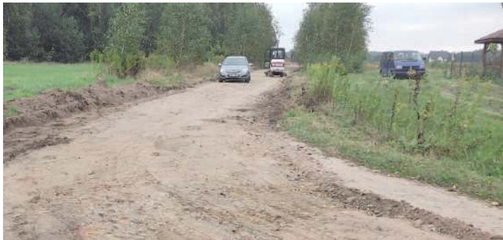
Tak przed wykonaniem prac wyglądała droga w Kozioł. Teraz mieszkańcy nie muszą jeździć przez błoto
