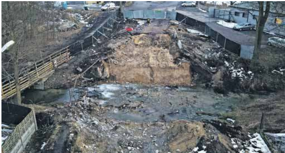
Stary most został już zlikwidowany. Budowy nowego nie można rozpocząć bez dopełnienia formalności
