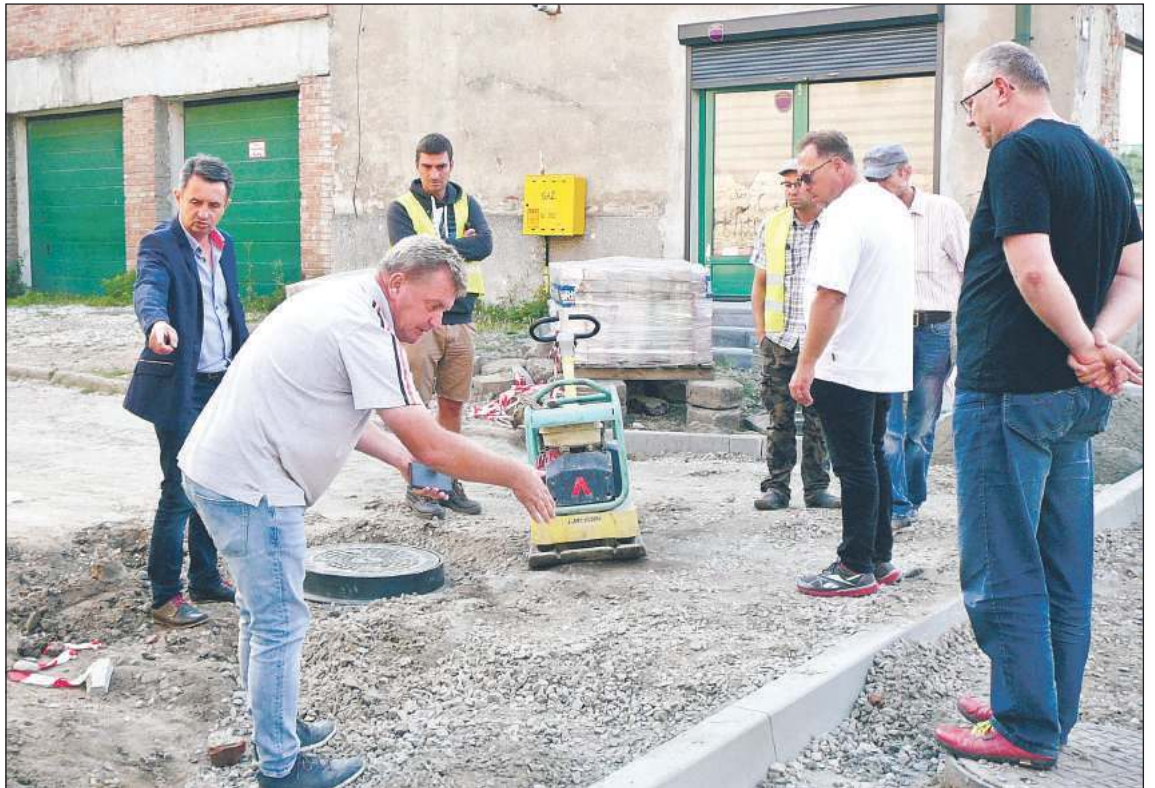
W miejscu, w którym znalezione zostały fragmenty macewy, inwestor wstrzymał prace.
