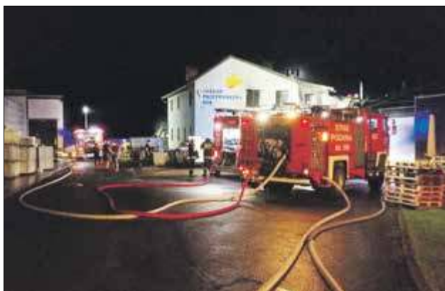
13 sierpnia przed godziną 22 doszło do pożaru na terenie zakładu PHU Elmar Zakład przetwórstwa ryb w Białej Podlaskiej. W wyniku pożaru zniszczony został budynek produkcyjny
