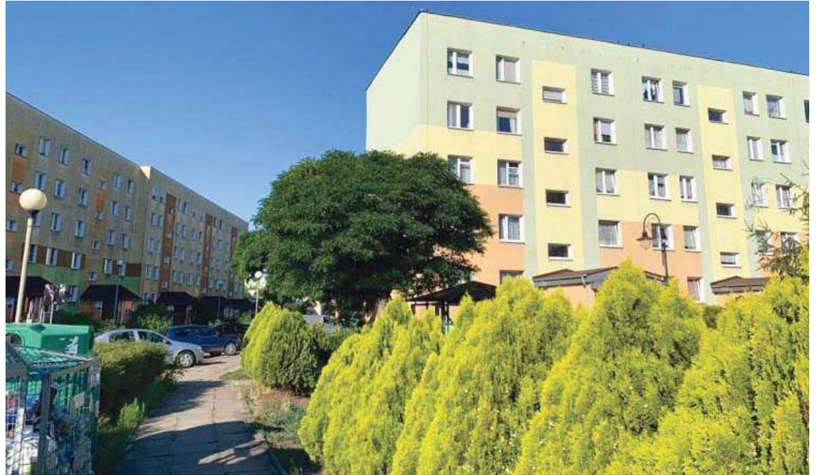
Oświetlenie uliczne na całej ul. Staszica nie działa już od dwóch miesięcy
