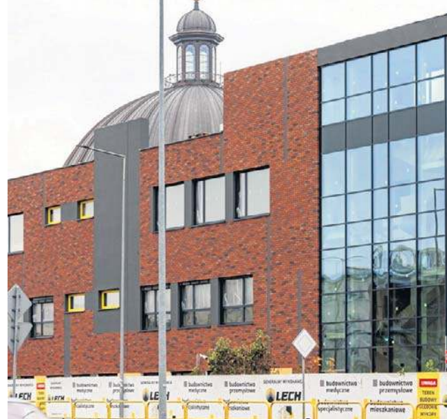
W obiekcie, który powstaje u zbiegu ulic Ogińskiego i Sieńki, aktualnie trwają prace związane z elewacją
