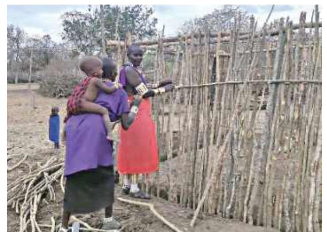
Budowa „domu tymczasowego” dla rodziny Karena. Ich obecny dom grozi zawaleniem
