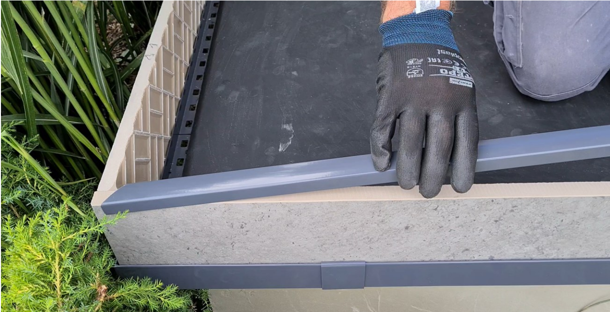
Fot. 4 Układanie płyt czołowych i montaż profilu okapowego
