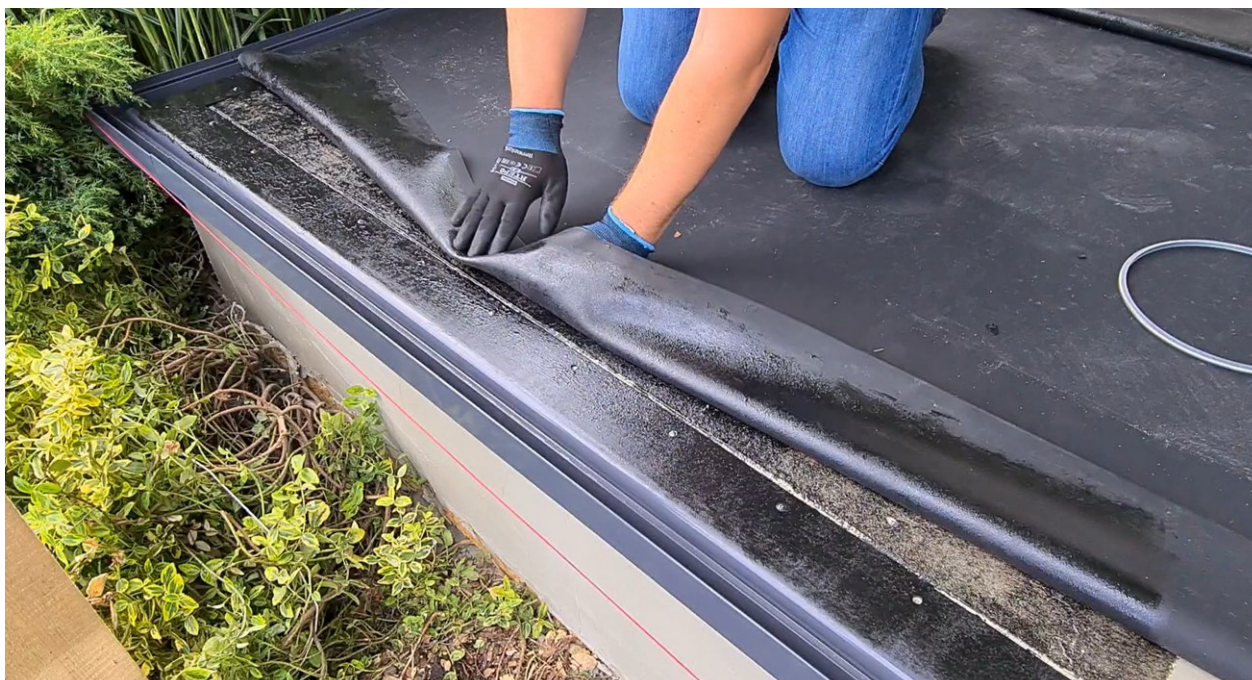
Fot. 3 Klejenie powłoki wodochronnej z membrany EPDM
