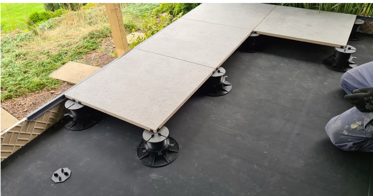
Fot. 5 Układanie płyt posadzki, profile okapowe zapewniają stabilność płyt w strefie okapowej oraz estetyczny wygląd
