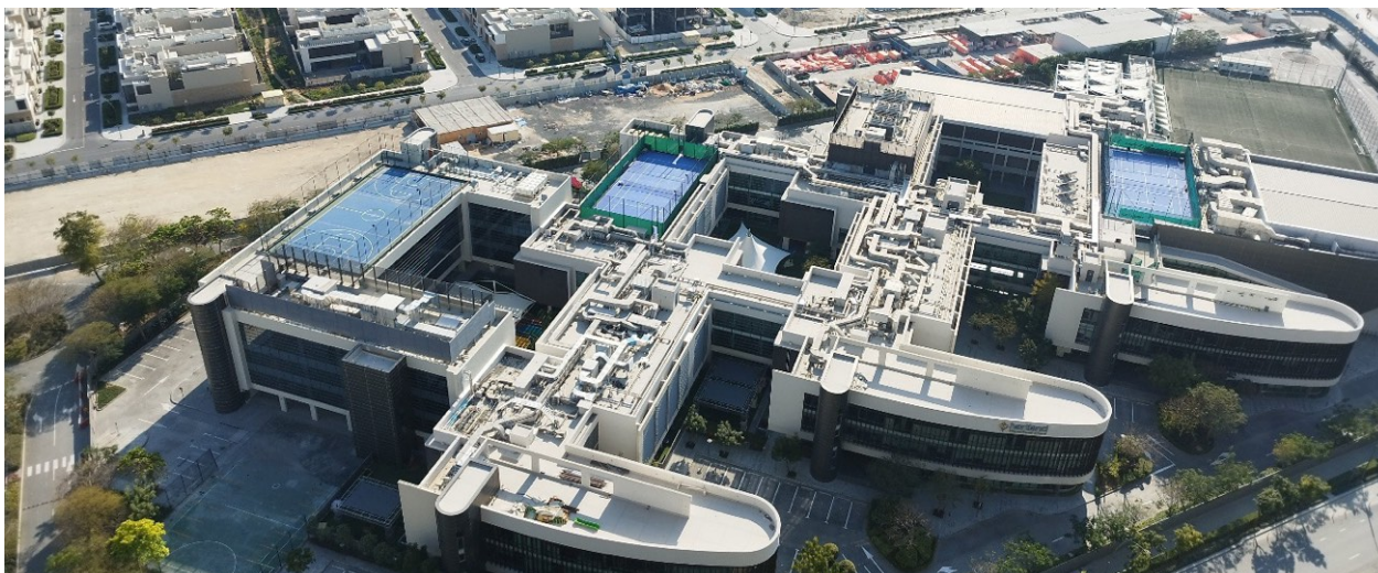
Kompleks budynków szkoły podstawowej w Zjednoczonych Emiratach Arabskich, Dubaj (2024); archiwum autorki
