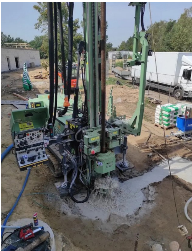
W Wartkowicach na potrzeby instalacji grzewczej wykonano wymiennik gruntowy złożony z dziewięciu odwiertów o głębokości 90 m. Prace przeprowadziła firma Budros PC
