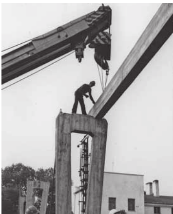
Budowa kładki nad torami
