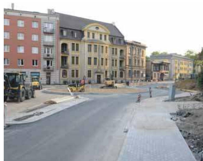
Rondo, którego budowa dobiega końca, usytuowane w pobliżu Sądu Rejonowego w Tarnowskich Górach, będzie nosić nazwę Stowarzyszenia Miłośników Ziemi Tarnogórskiej
