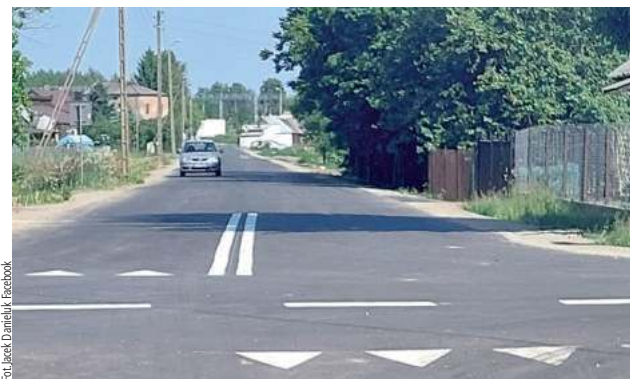
Ul. Orzeszkowej po przebudowie umożliwia dojazd z centrum Terespola do drogi krajowej
