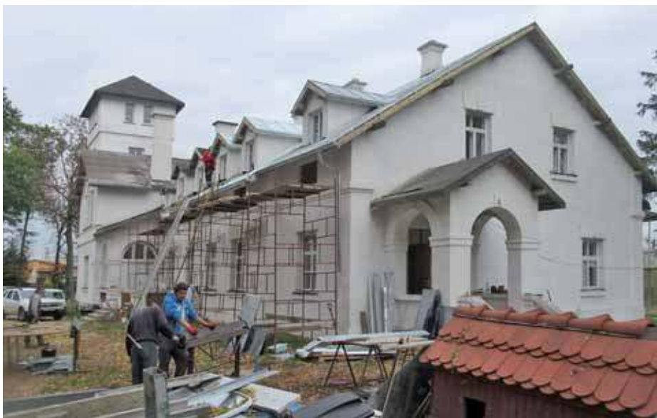
Właściciele już naprawiają dach
