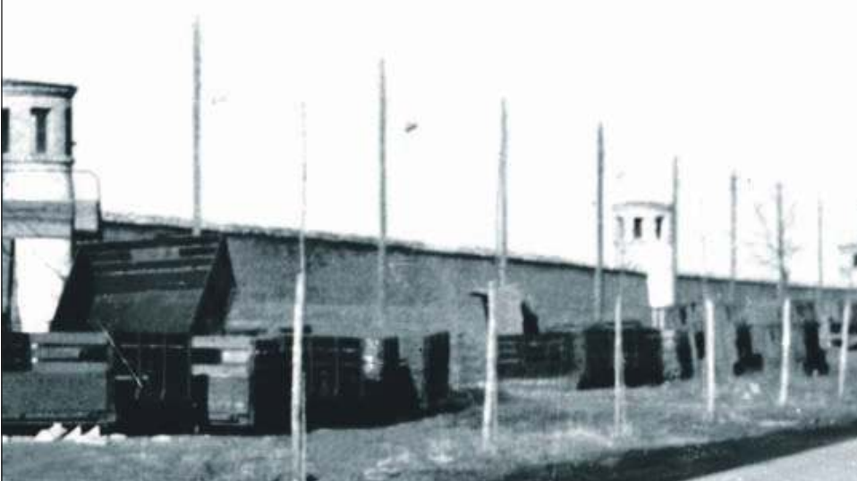
JELCZ Pod koniec 1952 roku, gdy obóz formalnie już działał, dobudowano wieżyczki do więziennych murów.
