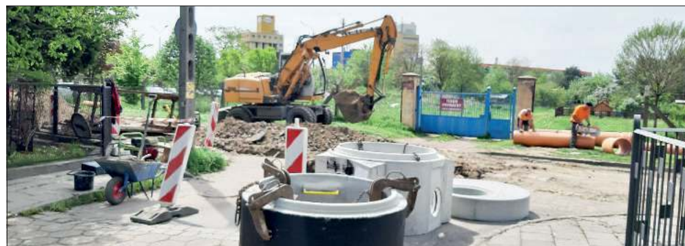
■ Aktualnie prace są prowadzone na odcinku ulicy Bolesława Prusa w rejonie skrzyżowania z ulicą Słoneczną. FOT. WOJCIECH ŻÓŁNECZKO
