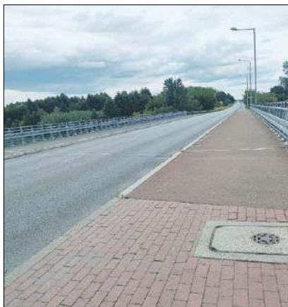
W ramach inwestycji przebudowana zostanie Al. Solidarności na całej długości
