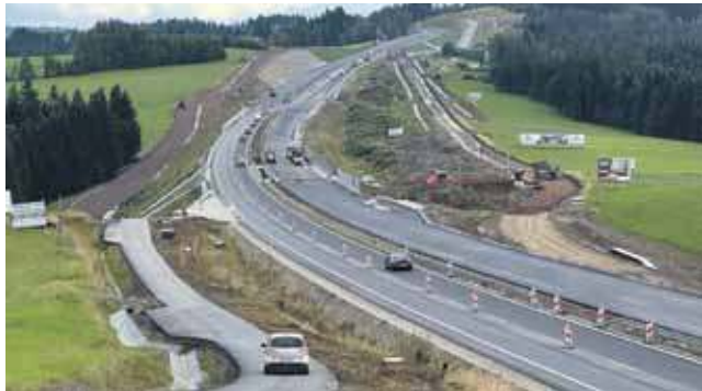
Budowa nowej zakopianki w rejonie Sołtysiej Doliny.
