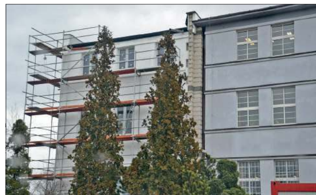
W dobudowanej części znajdzie się nowa klatka schodowa, winda oraz nowe biura
