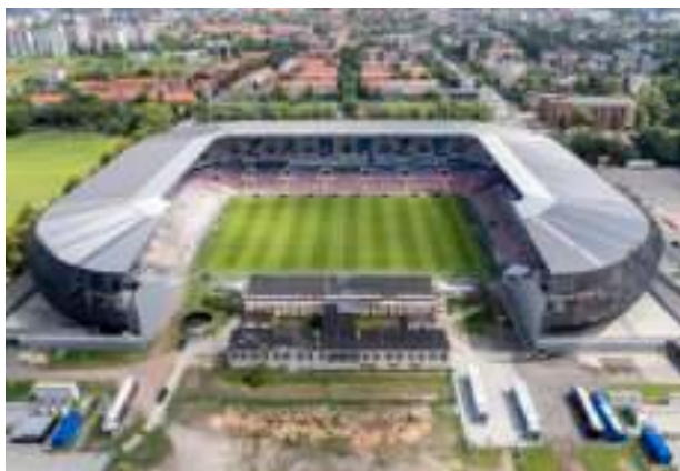
► Dokończenie budowy Areny Zabrze Fot. UM Zabrze
