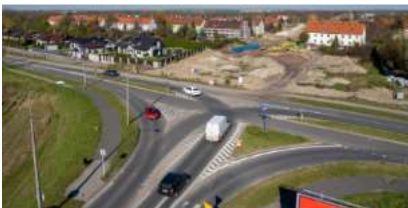
► Prace nad przedłużeniem alei Korfantego Fot. UM Zabrze
