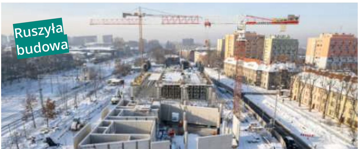
Ruszyła budowa centrum przesiadkowego przy ul. Goethego
