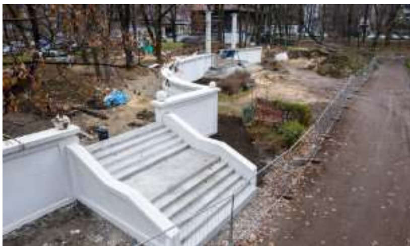
► Odnawiane są schody i mur przy wejściu do parku Fot. UM Zabrze
