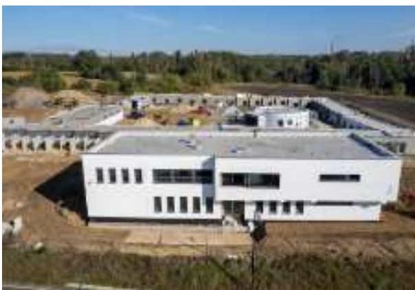
► Budowa schroniska dla zwierząt w Biskupicach Fot. UM Zabrze
