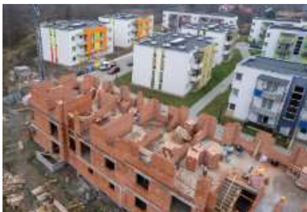
► Budowa kolejnych nowych mieszkań Fot. UM Zabrze
