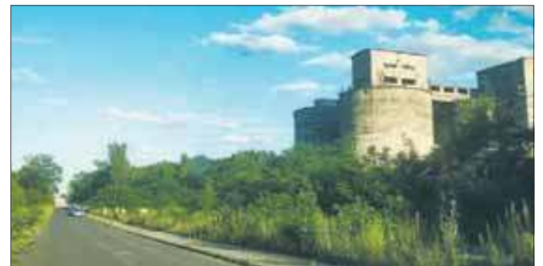
Teren cementowni jest niezabezpieczony
