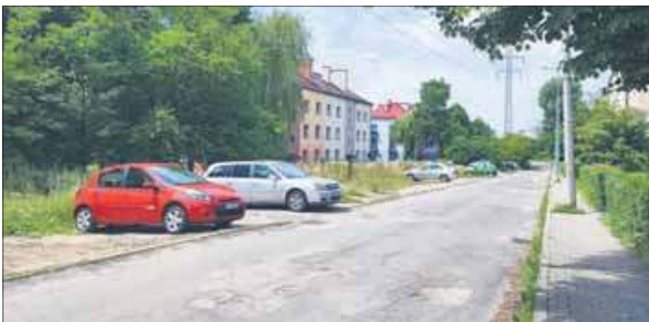
Remont drogi wkrótce się rozpocznie
