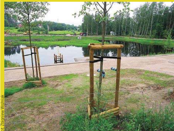
Budowa zbiornika retencyjnego na Likusach
