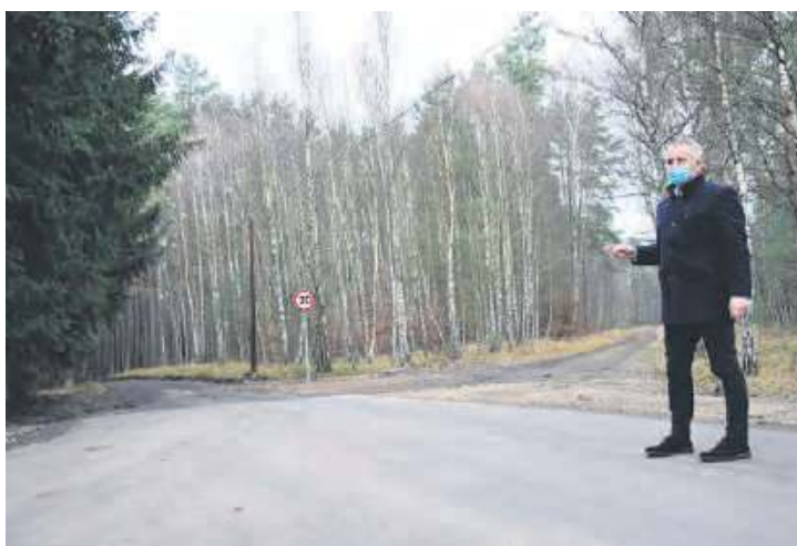
Miejsce zakończenia ubiegłorocznej przebudowy drogi do Łosin i początek realizacji drugiego etapu.
