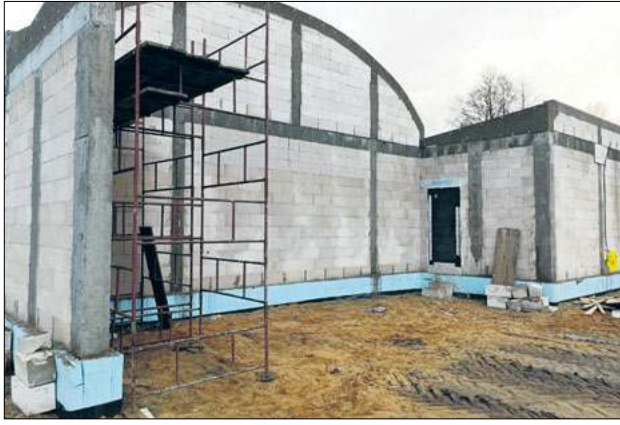
W Porosiukach powstaje scena, obecnie trwają prace wewnątrz budynku
