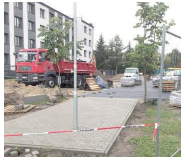
Parking przy Komendzie Policji w Biłgoraju w budowie
