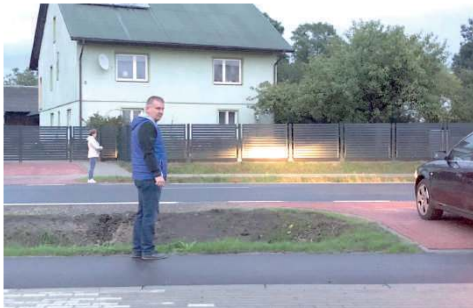
Dwa widoczne na zdjęciu przejazdy po przeciwnej stronie drogi przed remontem ułożone były w linii prostej. Działki po obu stronach drogi należą do jednej osoby (tak jest w wypadku wielu mieszkańców Korczowa - po jednej stronie ulicy dom, po drugiej pole). Ale w Korczowie wszystkie wjazdy zostały przesunięte: po jednej stronie drogi w prawo, po drugiej w lewo i teraz słomem trzeba przejeżdżać, żeby się na swoje pole dostać - tłumaczą mieszkańcy
