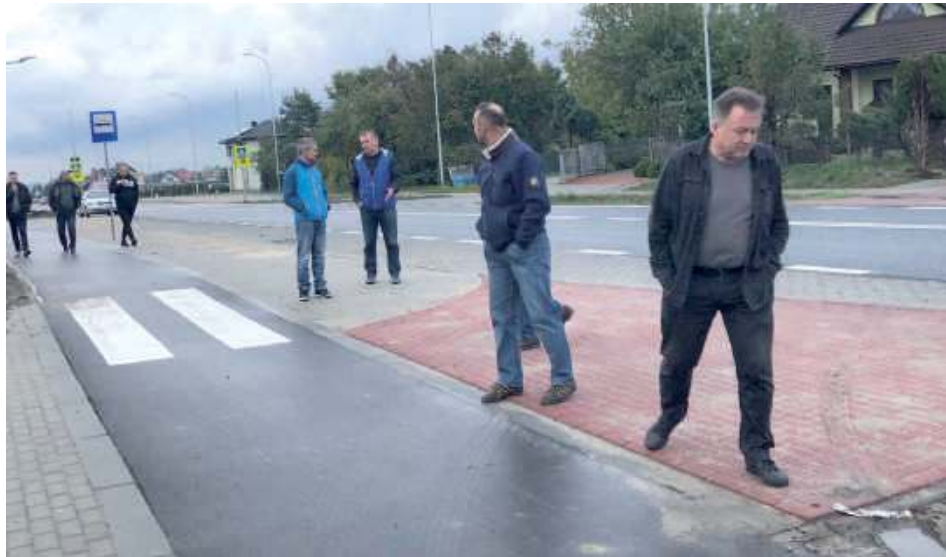
Jako „ciekawostkę” mieszkańcy Korczowa pokazali nam przejście dla pieszych przez ścieżkę rowerową, prowadzącą wprost na latarnię
