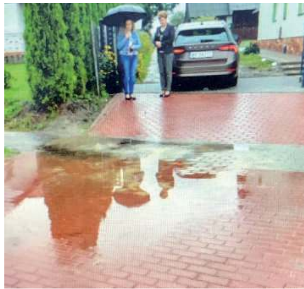
Na nowym podjeździe u pani Grażyny i Tadeusza po deszczu stała woda, bo nie było spływu. - W sobotę przyjechali i poprawili. To zdjęcie jest zrobione następnego dnia, w niedzielę, już po poprawkach. Jeszcze musimy te tuje wyciąć, bo cofnęły nam chodnik w stronę posesji i teraz jak wyjeżdżamy z posesji, to nic nie widać - tłumaczy pani Grażyna
