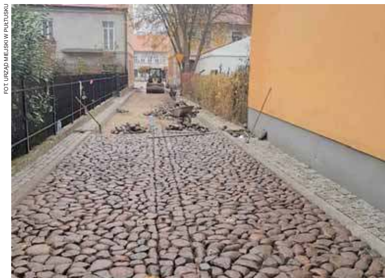
Obecnie trwają prace przy ul. Konserwatorskiej
