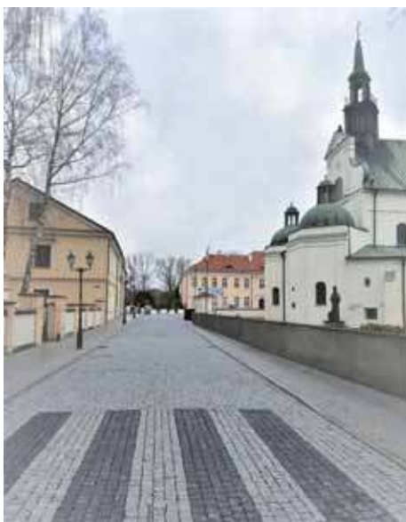
Ulica Marii Konopnickiej została wykonana z kostki granitowej, a chodnik z płyty granitowej
