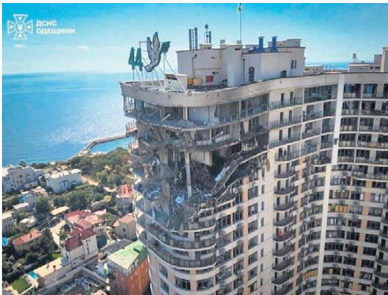
Rosjanie atakowali Odesę w nocy z soboty na niedzielę. Uszkodzono m.in. placówkę edukacyjną i wielopiętrowy budynek
