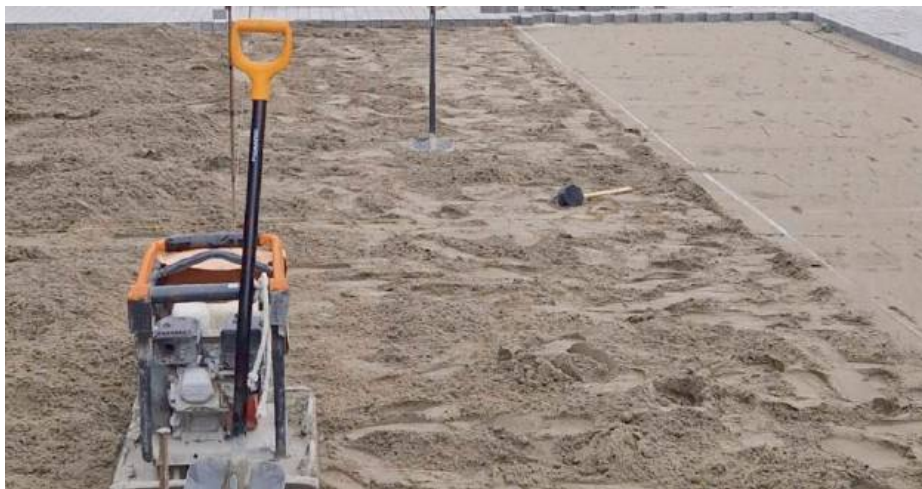
Prace remontowe trwają w kilku miejscach
