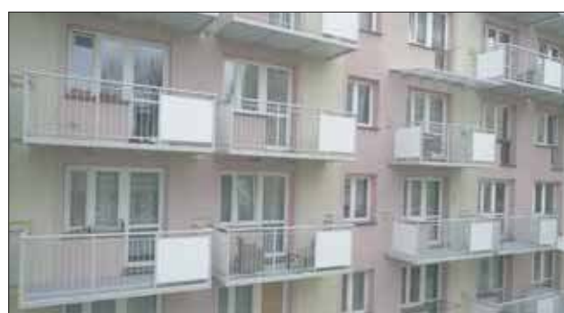
Koszt budowy balkonu to 10 tys. zł
