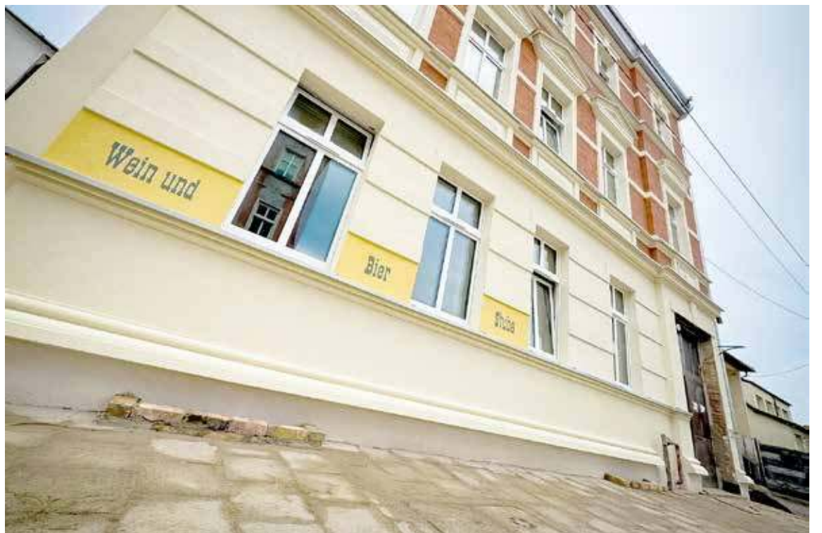
Odtworzono dawny napis Wein und Bier Stube czyli Izba Wina i Piwa. Tak po termomodernizacji wygląda kamienica przy Młyńskiej 10
