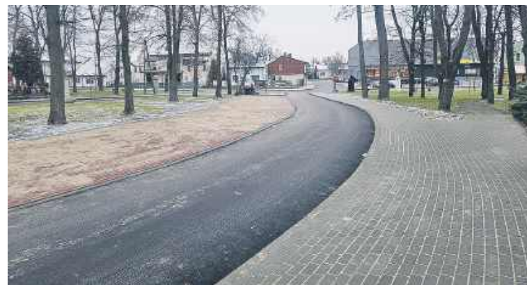
Wyremontowana ulica Kościelna w Siedliszczu
