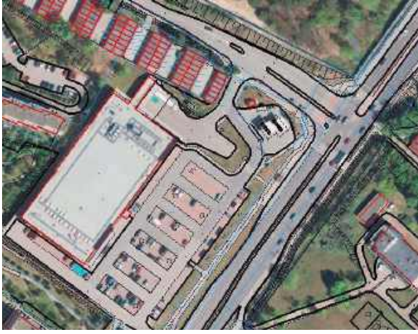
LEGIONOWO. SPN rozbudowuje stację na Piaskach
