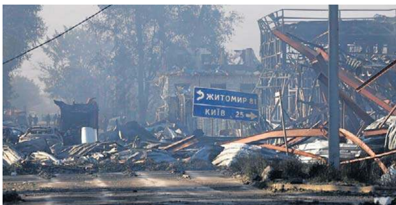
Pociski uderzyły w miejscowości Myła w pobliżu Buczy. Uszkodzone zostały także dom opieki oraz budynki prywatne.
