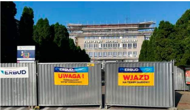
Otwarcie odnowionego, głównego wejścia planowane jest na koniec tego miesiąca
