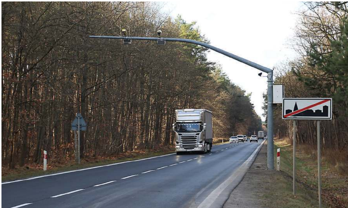
Urządzenia do odcinkowego pomiaru prędkości zostały już zamontowane
