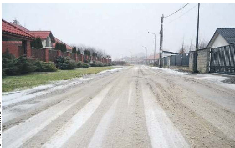
Ulica Dworska ma zostać przebudowana do lipca 2022 roku 230 tysięcy złotych. Na inwestycję samorząd uzyskał dofinansowanie z Rządowego Funduszu Rozwoju Dróg w wysokości blisko miliona 188 tysięcy złotych.
