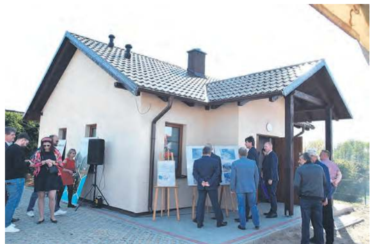
Inwestycja obejmowała także utwardzenie terenu kostką brukową.
