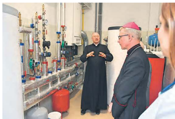
Nowoczesna kotłownia, która powstała w ramach projektu.
