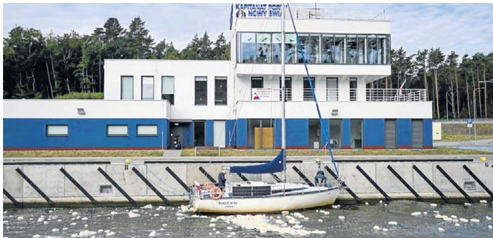
Z przejścia kanałem przez Mierzeję Wiślaną korzystają na razie głównie jachty
