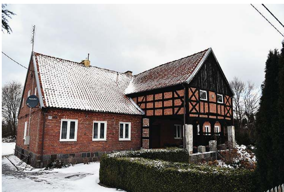
Kamiennik Wielki. Według karty ewidencyjnej zabytków dom prawdopodobnie wzniesiony w XVII w., pierwotnie drewniany. Podcień szczytowy z 1787 r. zgodnie z datą na chorągiewce nad szczytem wystawki. Później wielokrotnie przebudowywany, ostatecznie rozbudowany o długą oborę. Obecnie zapadła się konstrukcja dachu w części mieszkalnej i odstąpiła beczułkowaty kształt ceglanego komina nad czarną kuchnią. Podcień wsparty sześcioma słupami na postumentach. Słupy wzmocnione dekoracyjnie wyciętymi mieczami
