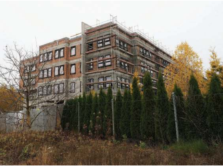
Kompleks szkolno-kulturalny przy Berylowej jest już w stanie surowym zamkniętym
