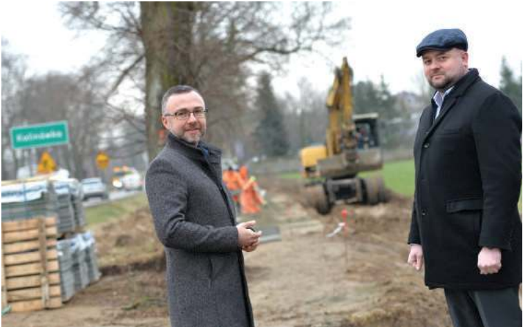
Powiatowe remonty z dofinansowaniem FDS rozpoczęły się od przebudowy drogi Lublin-Kalinówka. W ubiegłym tygodniu co się dzieje na placu budowy sprawdzali starosta Łukasz Reszka i wicestarosta Bartłomiej Pejo
