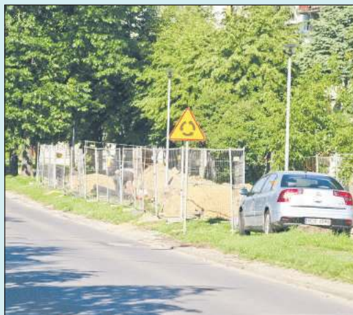
Trwa przebudowa chodnika przy ul. Tysiąclecia.
