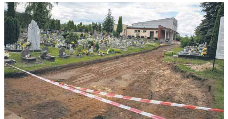
Chodniki przejdą gruntowny remont
