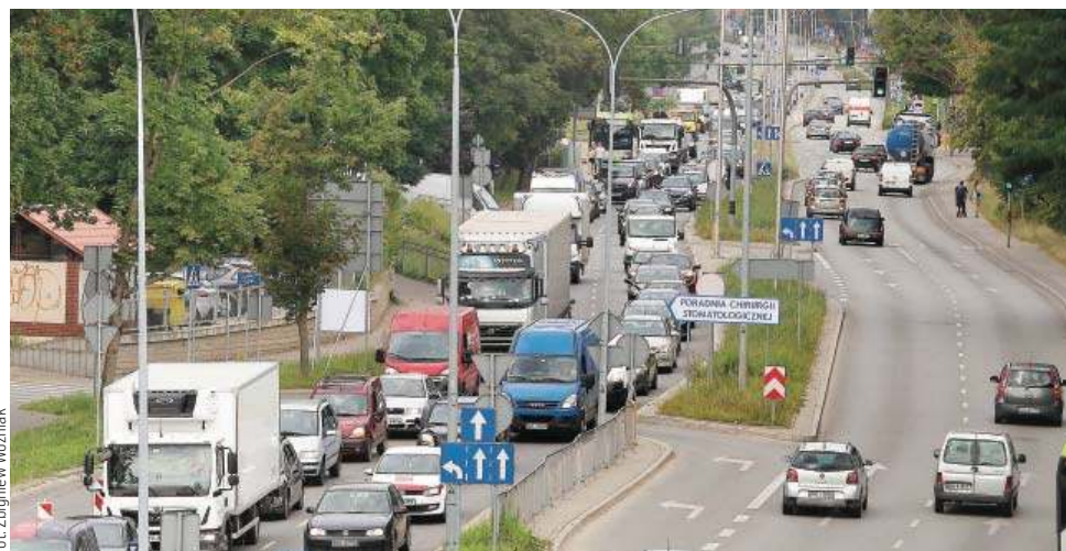
Wśród projektów strategicznych znalazła się budowa nowej ulicy Bałtyckiej w Olsztynie, dzięki której Bałtycka (na fot.) stanie się drogą miejską
