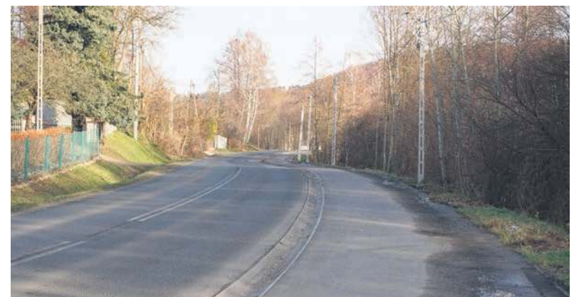
Ciąg pieszo-rowerowy wzdłuż ul. Prusa w Alwerni
