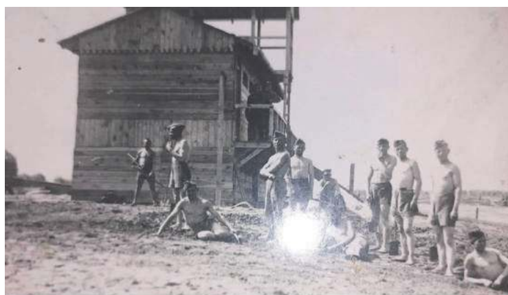
Pierwsza przystań wybudowana w 1914 roku dla Pułtuskiego Towarzystwa Wioślarskiego, w trakcie budowy.
