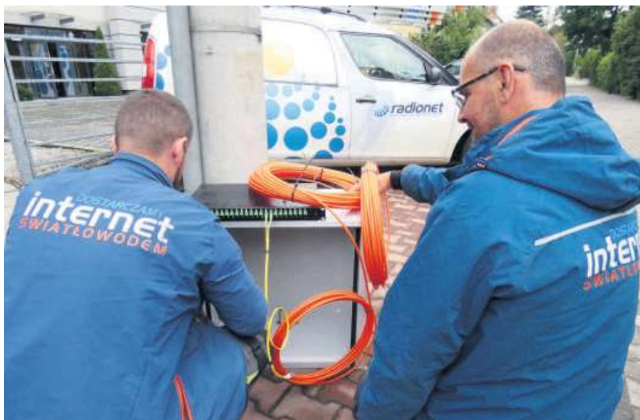
Jeszcze w tym roku powinno ruszyć podłączanie do światłowodowego internetu pierwszych odbiorców. Wykonawcą będzie znana w powiecie lokalna firma Radio-Net
