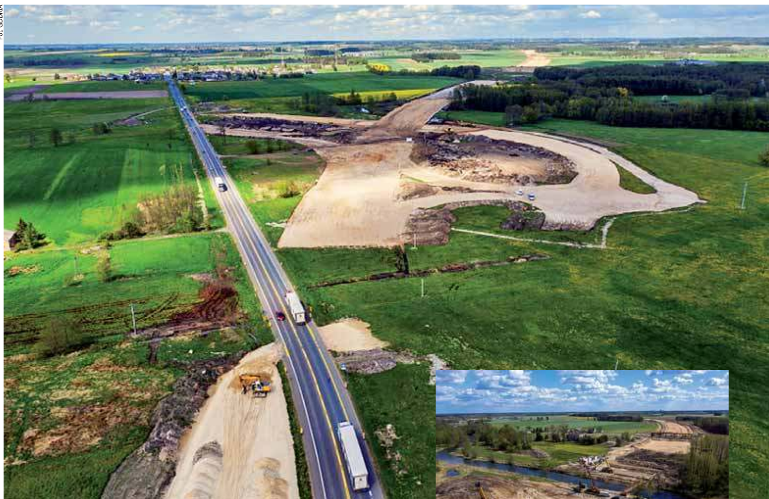
Inwestycja jest podzielona na cztery odcinki realizacyjne
