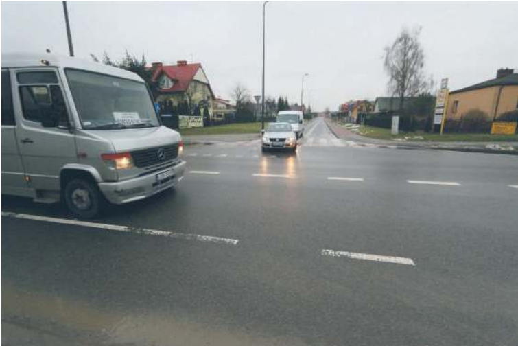
W godzinach szczytu ciężko wyjechać z ulicy Klonowej i Rejkowizna na aleję Lotników Polskich, ale zapowiadana budowa w tym miejscu mini ronda, które częściowo rozwiązałoby ten problem musi poczekać na realizację
