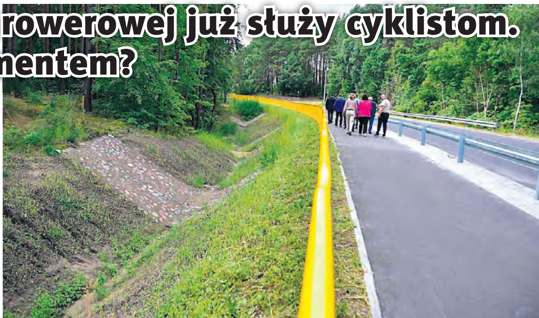
Formowanie nasypu było jednym z bardziej czasochłonnnych etapów inwestycji. Prace utrudniały wody spływające z okolicznych pól oraz opady deszczu.
