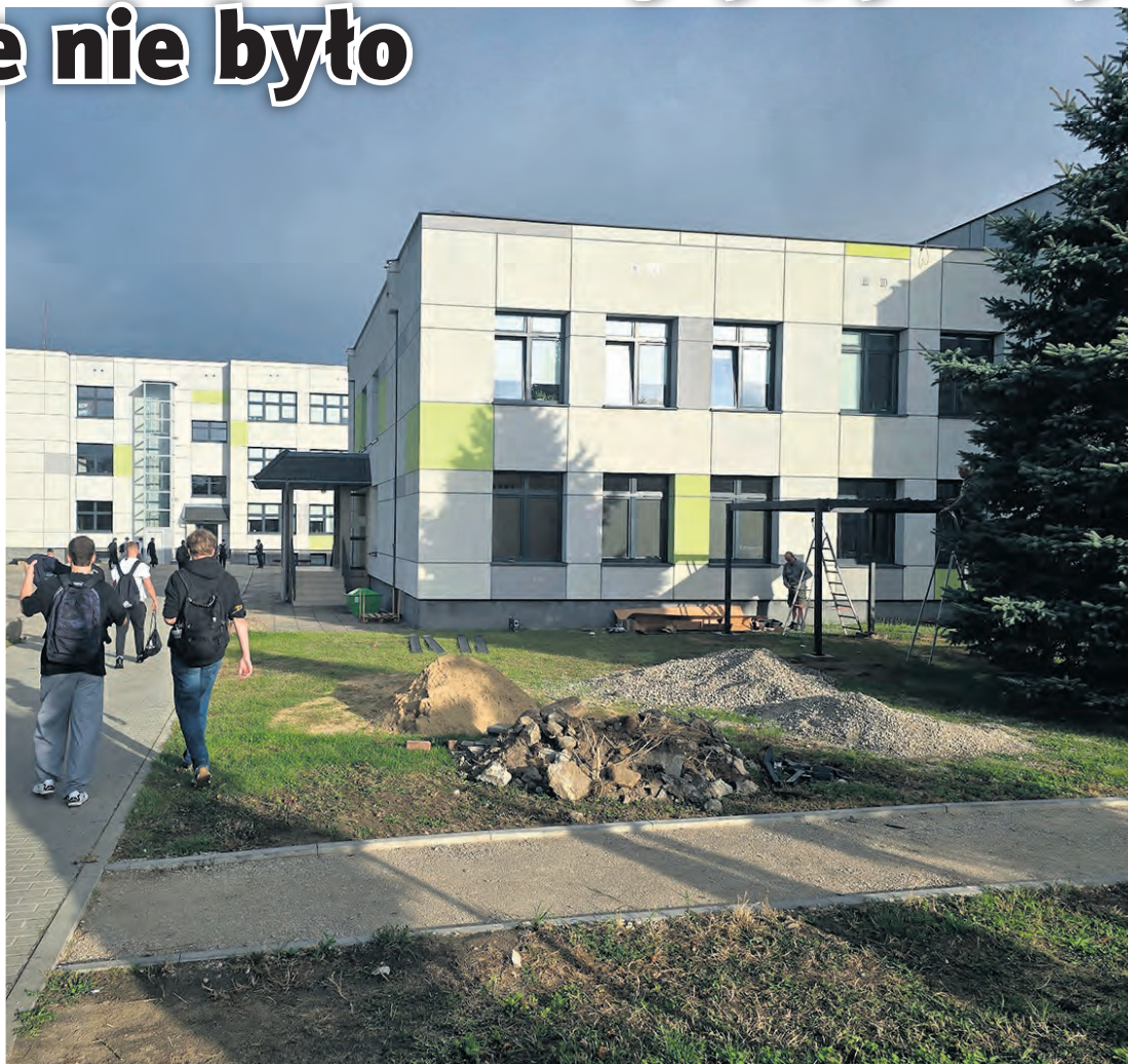
Na terenie tucholskiego ogólniaka trwają prace przy eko-ogródkach. Za kilka miesięcy zazieleni się również część dachu budynku.
