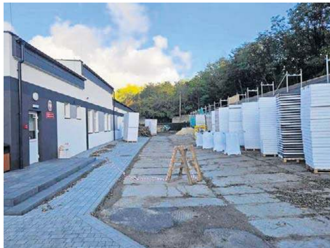
W Czeladzi trwa rozbudowa Sądu Rejonowego
